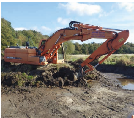
Création d'un méandre sur l'Ellé à Langonnet
