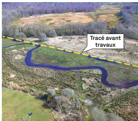
Après travaux sur l'Ellé à Langonnet : 2 méandres créés
