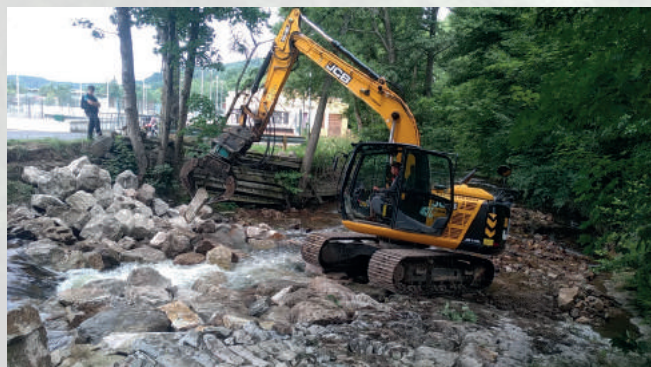
Sécurisation du seuil du Boulodrome à Dunières
