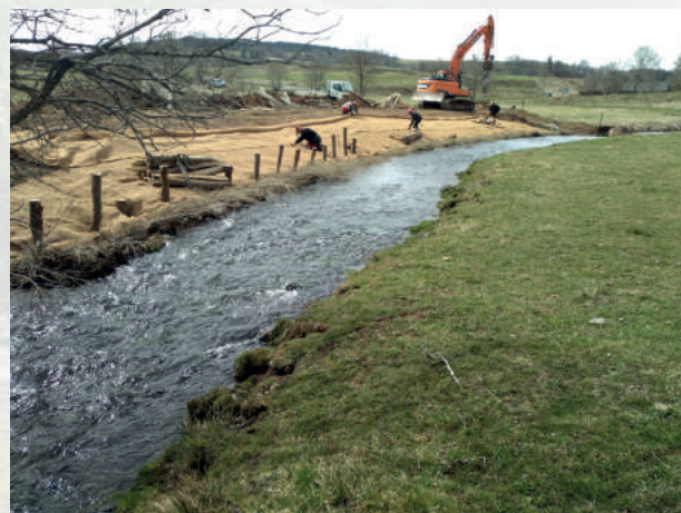
Restauration de berge érodée en génie végétal
