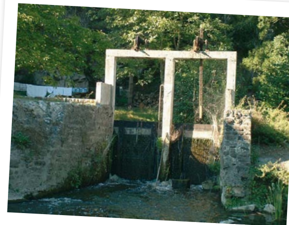
Barrage du pont, à Saint-Cénéri-le-Géréi (61)
