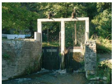
Barrage du pont, à Saint-Cénéri-le-Géré (61)
