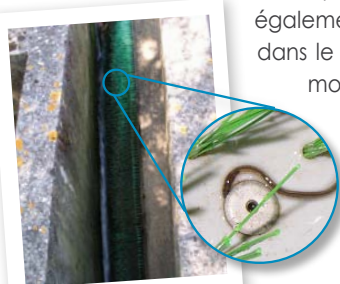
Passage à civelles au moulin d'Aché, à Chenay (61)
