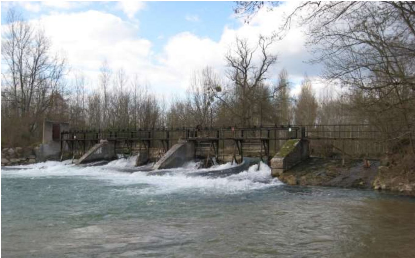
FIGURE 46: BARRAGE DU MOULIN DE CHAMPDOTRE RESTAURE ET EQUIPE EN 2015 POUR LA PRODUCTION D'HYDRAUELECTRICITE
