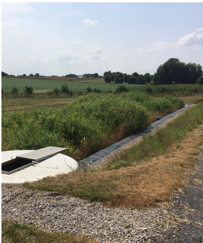
© CUA - Station d'épuration d'Hennerville
