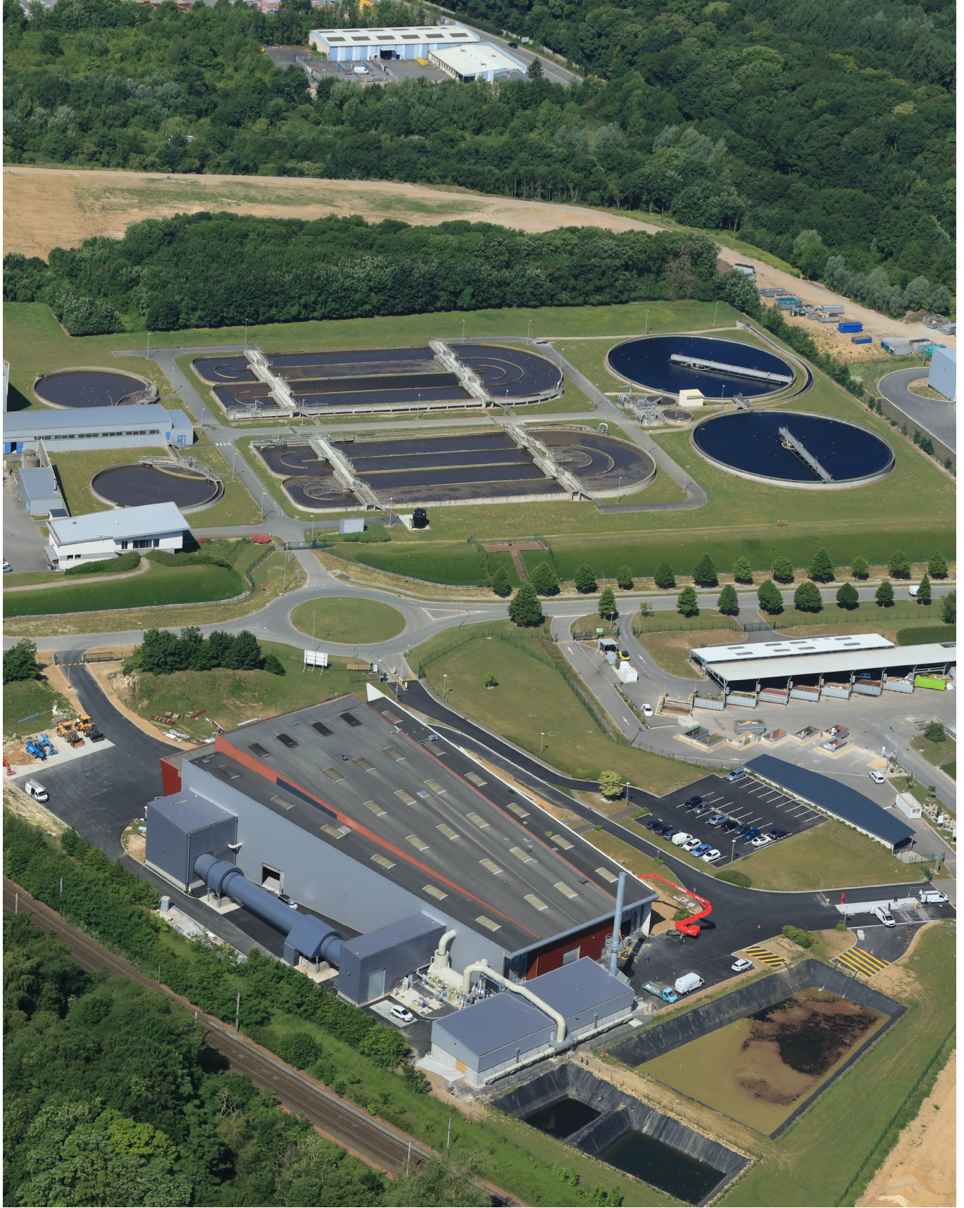
© Philippe Frutier - Altimage - Station d'épuration de Saint-Laurent-Blangy
