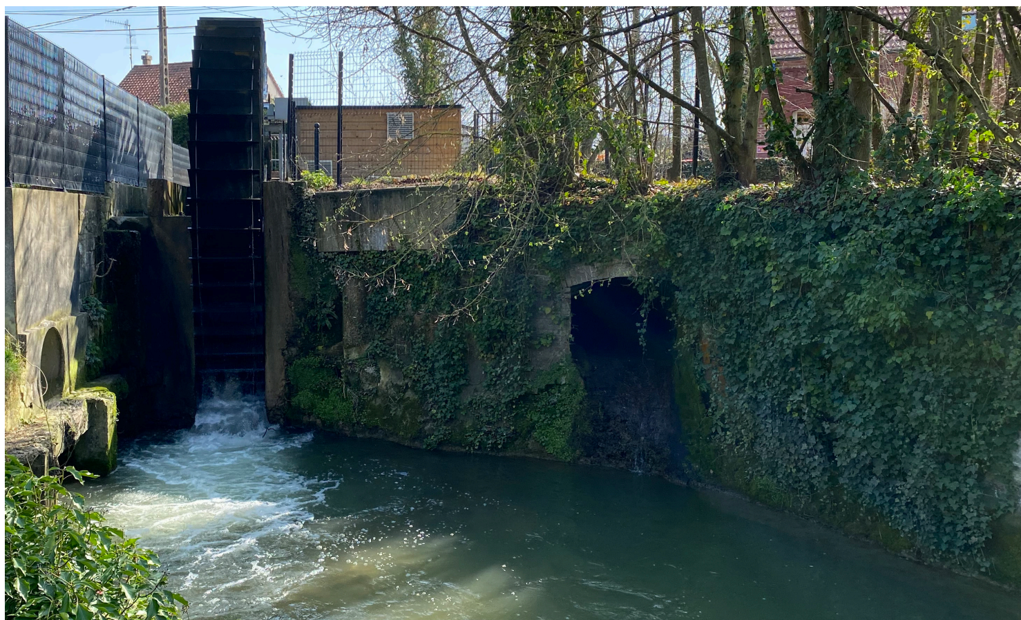
© CUA - installation hydro-électrique à Goeulzin
