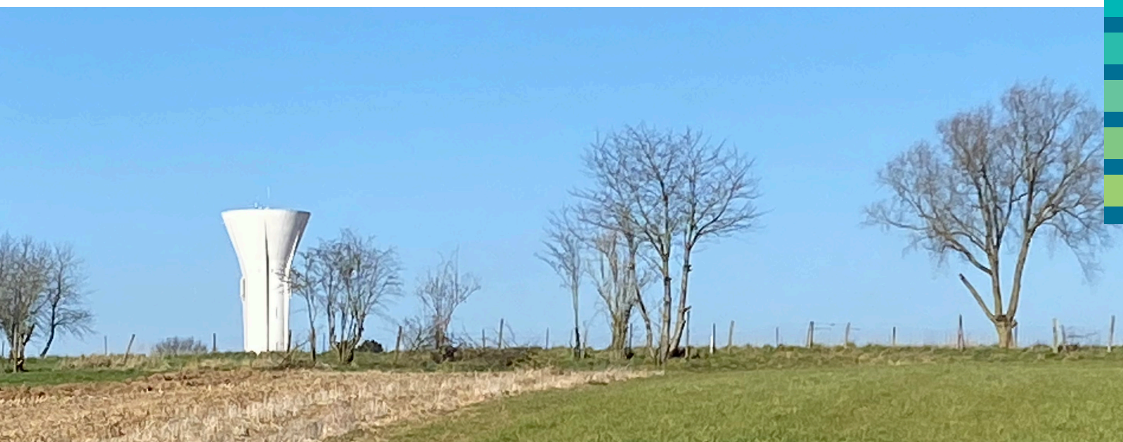
© CUA - Réservoir d'eau potable de Rivière
