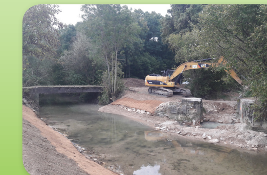
Arasement de l'ouvrage partiteur Norges-Goulotte à Chevigny Saint Sauveur (2016, SITNA)
