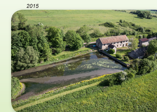
Effacement du barrage du Moulin du Martinet à Pellerey sur l'Ignon (2014-2016, SITIV)
