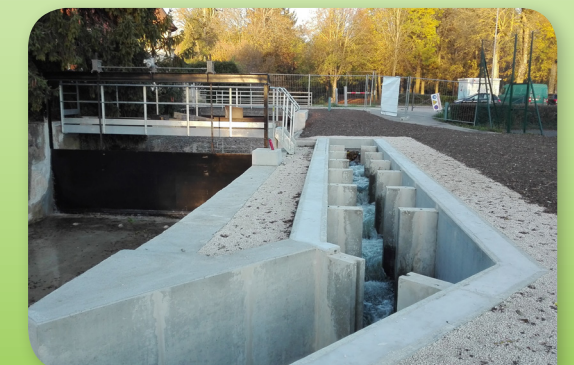
Modernisation du barrage de Couternon et création d'une passe à poissons (2017, SITNA)
