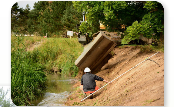
Restauration de la Goulotte et de la Rivière Neuve à Chevigny Saint Sauveur (4 km, SITNA, 2016)
