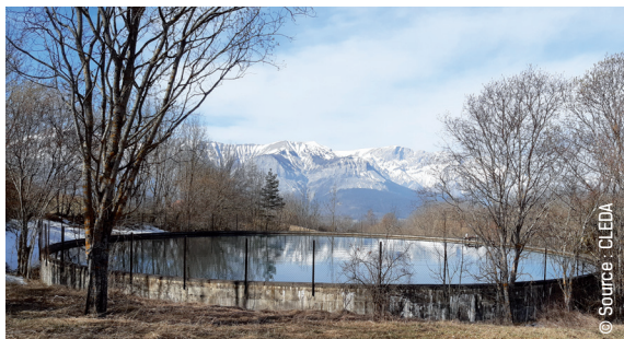
Réservoir Fontenil à Saint-Bonnet-en-Champsaur
