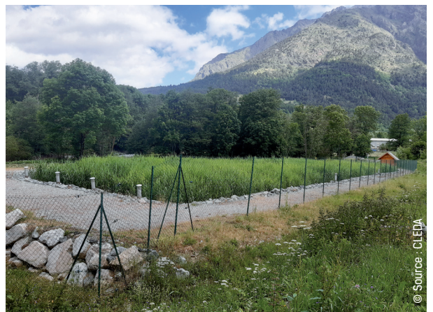
Station d'épuration sur la commune de la Motte-en-Champsaur réalisée dans le cadre du 1 er Contrat de rivière
