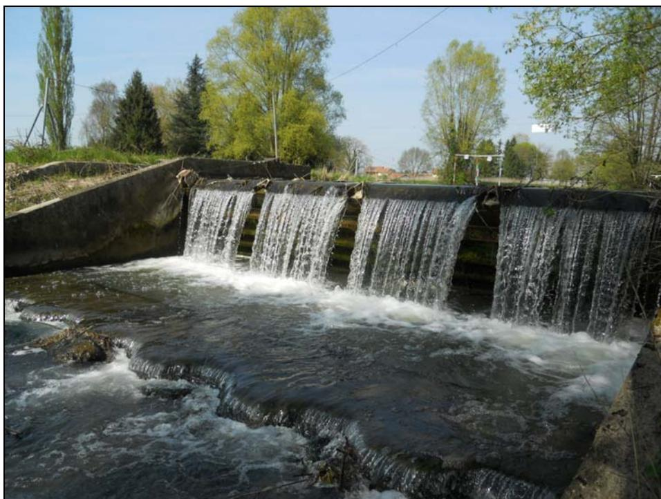
*Vanne clapet automatique du moulin de Curtafray*
