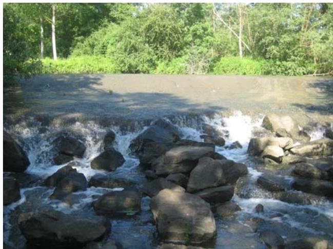
Une autre variante consiste à conserver l'ouvrage actuel en l'état pour un fonctionnement en crue et à créer une prise d'eau aval pour faire transiter le débit réservé dans une rivière de contournement. Compte tenu de la chute occasionnée par le déversoir actuel (2 mètres), la rivière de contournement fera une longueur d'environ 200 mètres pour une pente moyenne de 1 %.
