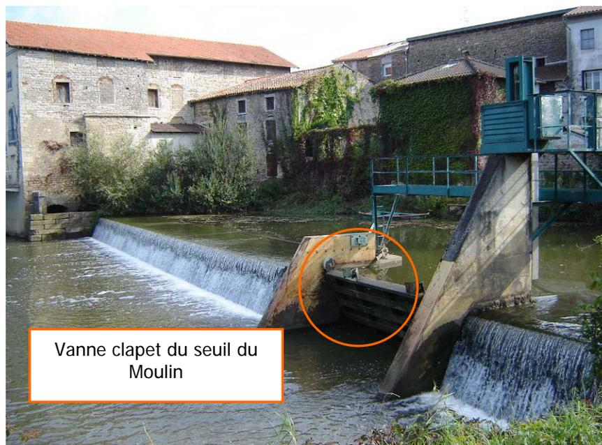
En cas de crue de la Reyssouze pour des conditions moyennes de la Saône, le seuil du Moulin n'est pas noyé et l'ouverture du vannage joue un rôle important dans l'abaissement de la ligne d'eau en amont de l'ouvrage et donc dans la limitation des débordements en direction des enjeux.
