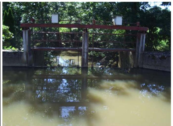
*Vannes guillotines électrifié en position basse (étiage)*
