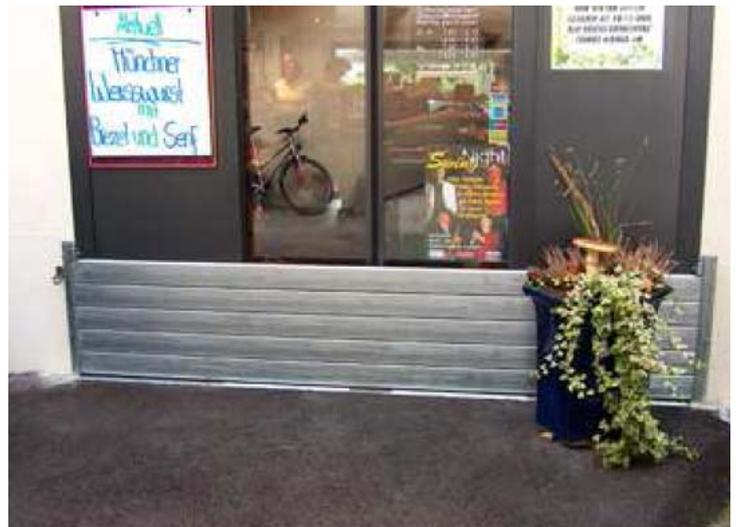
L'installation des batardeaux permet une mise hors d'eau complète du bâtiment même pendant des inondations exceptionnelles (hors remontée des eaux souterraines et du refoulement des réseaux).
