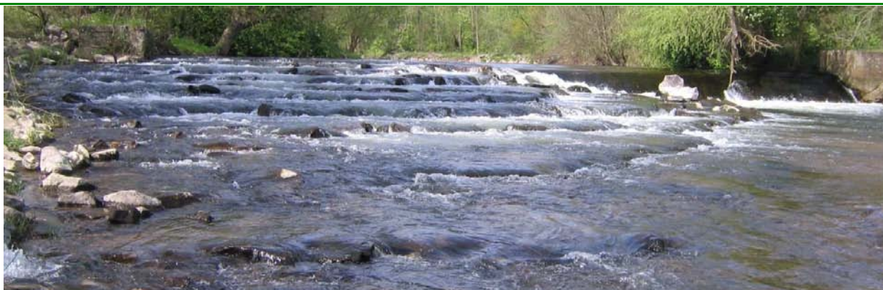
Photo. 2 : exemple de l'ouvrage de Kolbsheim sur la Bruche (67) : à gauche la rampe rugueuse franchissable, à droite l'ancien seuil toujours visible et infranchissable (Photo Fluvial.IS)
