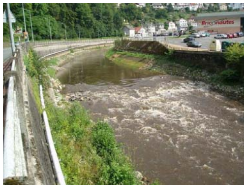
Ouvrage après travaux
