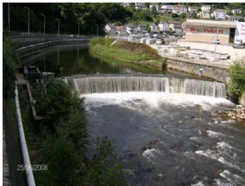
Ouvrage avant travaux
