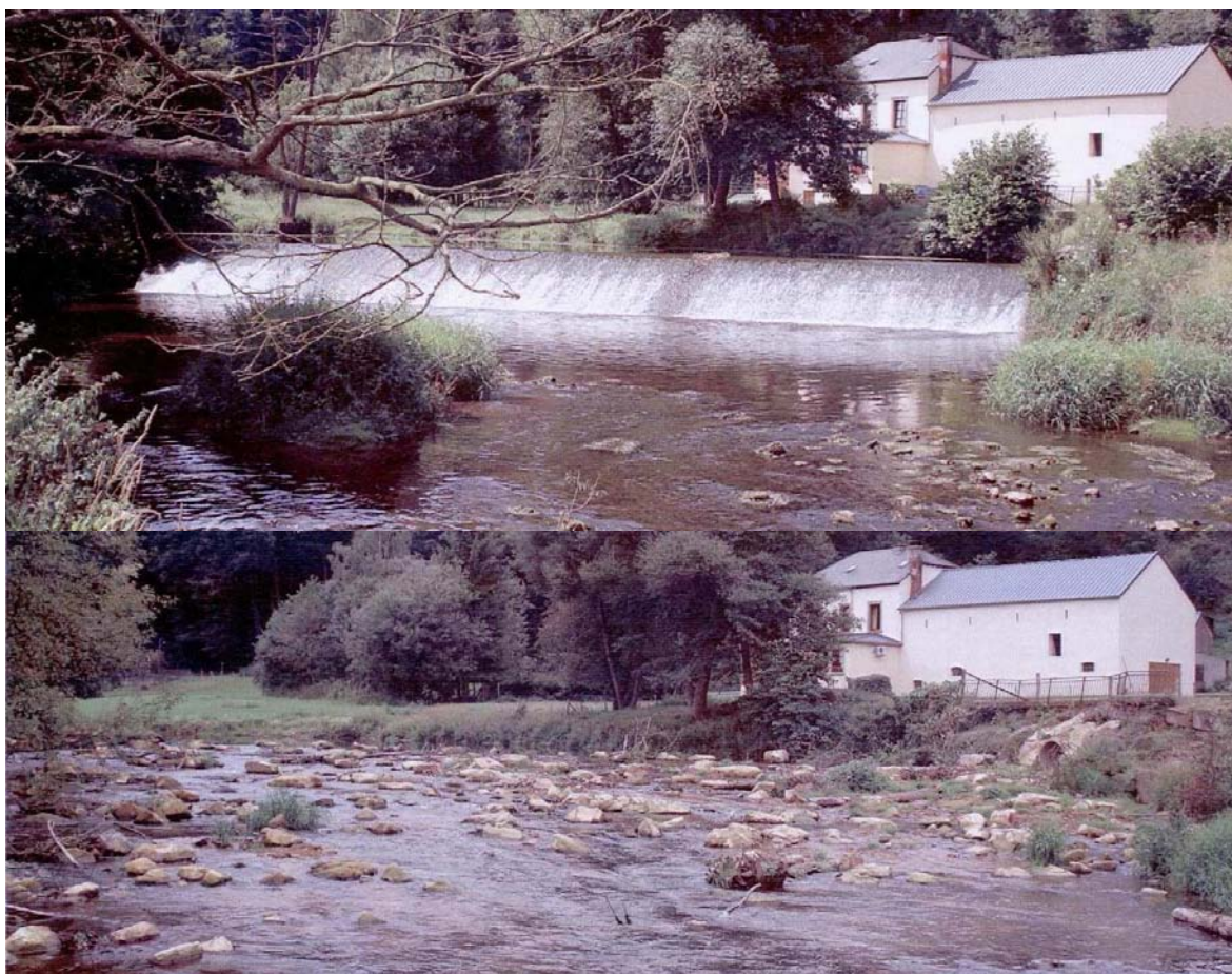
Photo. 3 : un exemple d'aménagement total en rampe rugueuse sans abaissement de la ligne d'eau : l'ouvrage de Boevange au Luxembourg (photo Adm. de l'Eau du Luxembourg)
