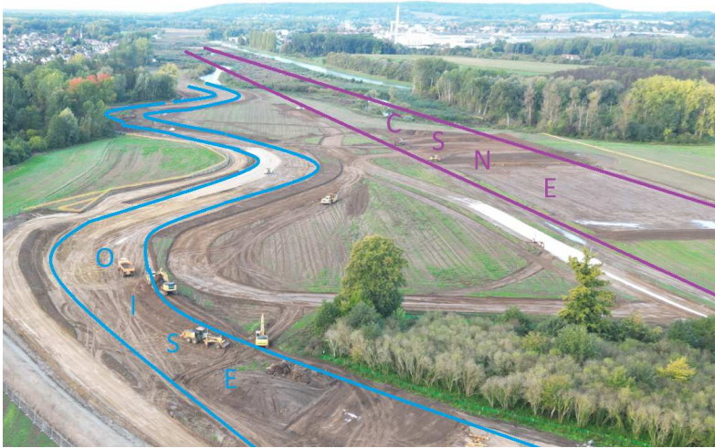
Automne 2022 : chantier Montmacq / Cambronne
