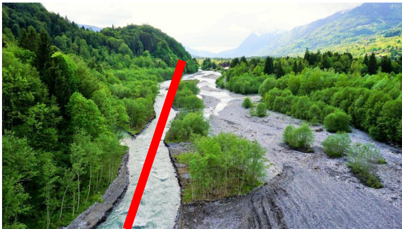
Création d'un chenal d'écoulement Site des Millières
