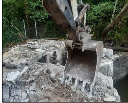
Photos 1 et 2 : Déconstruction du bâti de l'ancienne station de pompage
