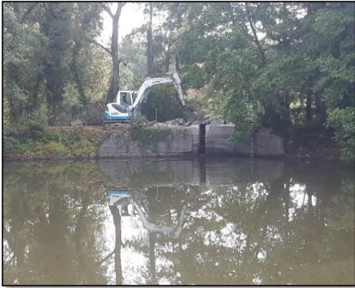
Photos 1 et 2 : Déconstruction du bâti de l'ancienne station de pompage
