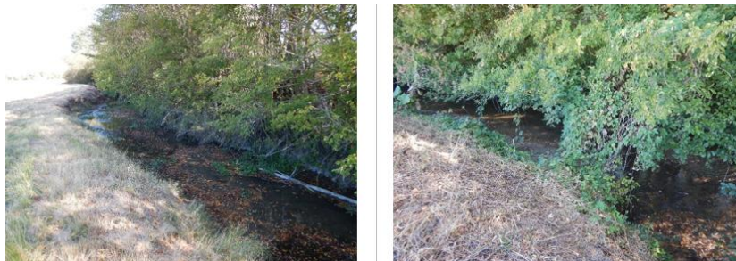
Figure 36 : Vues de la station du Saint-Martin à Guilly [Bois de Lazé]
