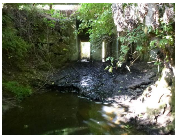
Tronçon Og7 : Lit enfoncé et radier de pont infranchissable
