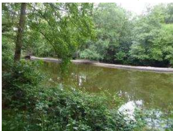
Ouvrage n°48 – (reconnaissance)
