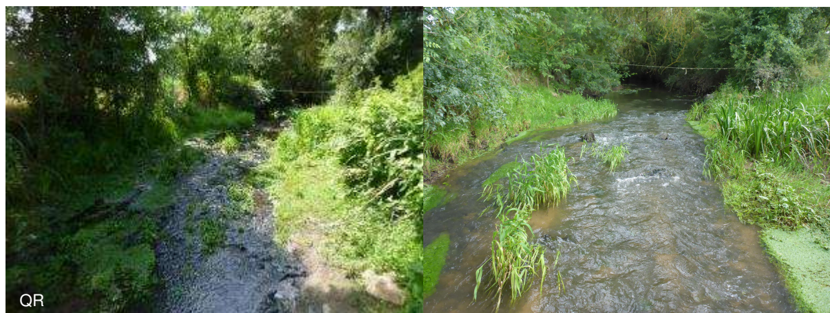
Ouvrage n°63– (QR et Q2)
