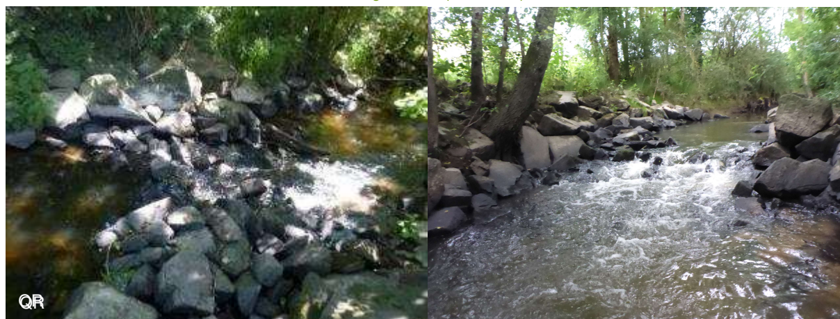
Ouvrage n°59– (QR et Q2)
