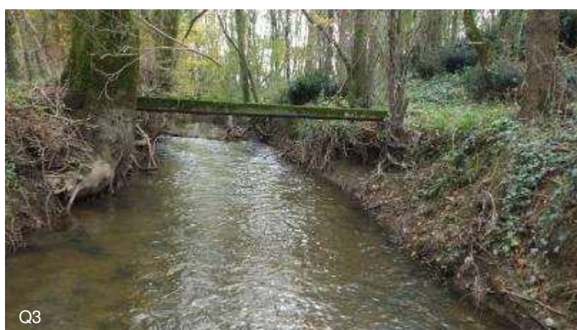
Le radier 72 (Q modélisation : 14 l/s jaugé au niveau de la station, Q2 : 532 l/s et Q3 : 1030 l/s au niveau de la station de l'Issoire, à Saint Philbert de Bouaine)
