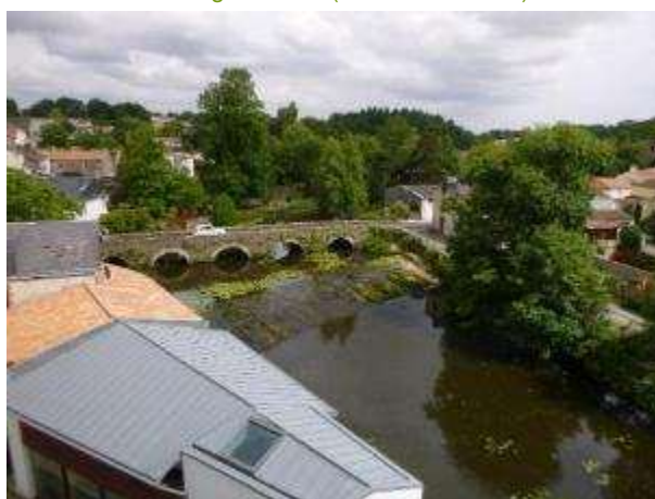
Ouvrage n°50 – (reconnaissance)
