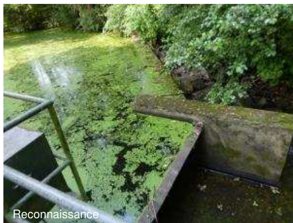
Ouvrage n°37 – (reconnaissance)
