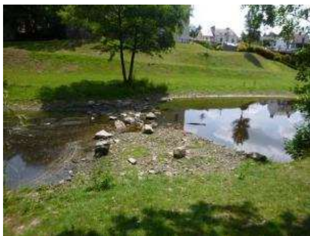
Tronçon Lo 1 : Micro-seuil et chenal lentique en amont
