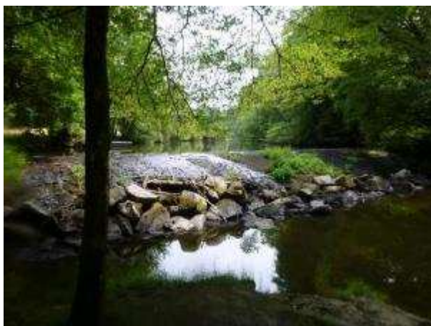
Ouvrage n°49 – (reconnaissance)
