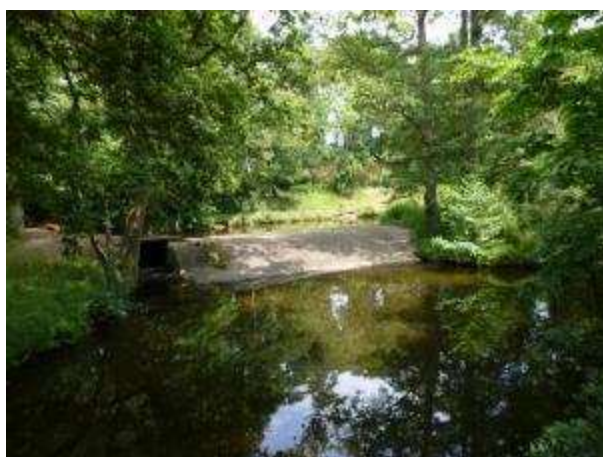
Ouvrage n°43 – (reconnaissance)
