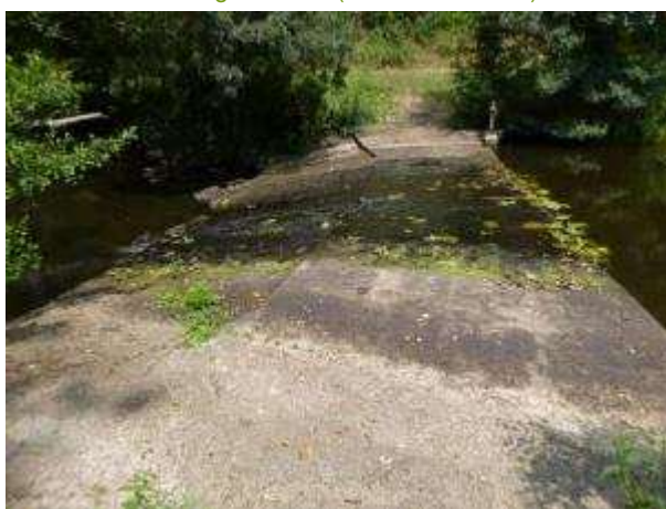
Ouvrage n°44 – (reconnaissance)
