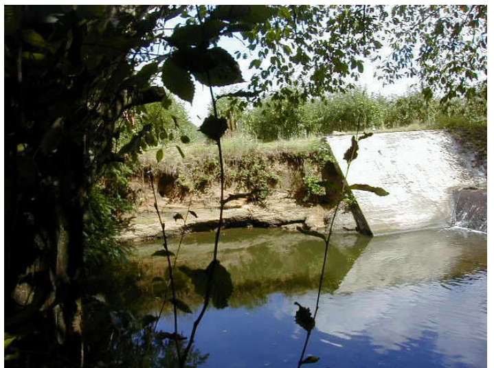
28 : Erosion en aval d'un seuil (Dhuy, Parc Floral)
