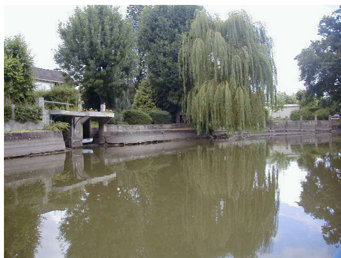
34 : Murets à base érodée par le batillage (Loiret)
