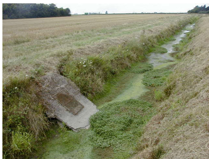
32 : Exutoire de drainage agricole (Ousson)
