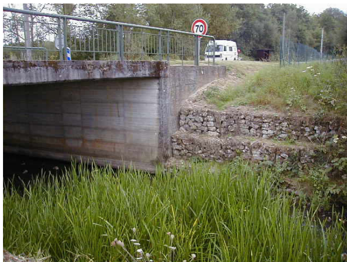
29 : renforcement de la berge en aval d'un pont par des gabions (Dhuy)
