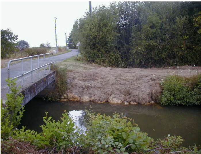
27 : Renforcement de la berge : enrochements + terre (Dhuy)
