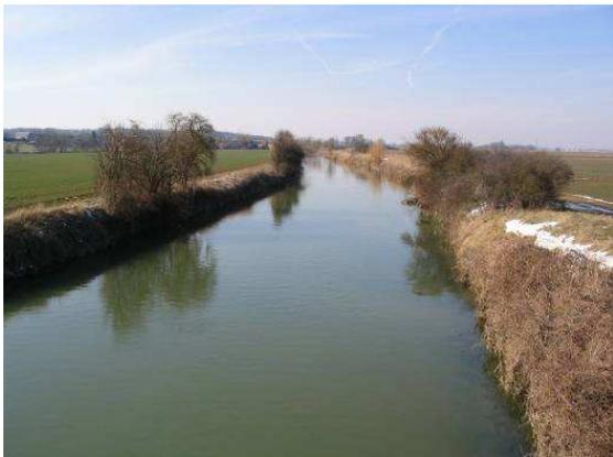
On retrouve un cours d'eau accusant un tracé en long rectiligne consécutif aux nombreux travaux de correction du cours. Sur l'ensemble du secteur le fond du lit est homogène et plat.
