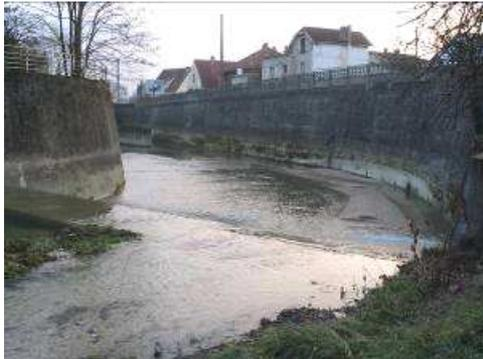
On note une nette dégradation de la morphologie dès l'entrée du cours dans l'agglomération dijonnaise (zone artisanale d'Ahuy) avec des berges artificialisées (enrochement, retalutage) et un lit très encaissé. Les assecs récurrents laissent temporairement des zones d'eau stagnantes de mauvaise qualité. Les dépôts d'immondices sont fréquents sur cette zone.
