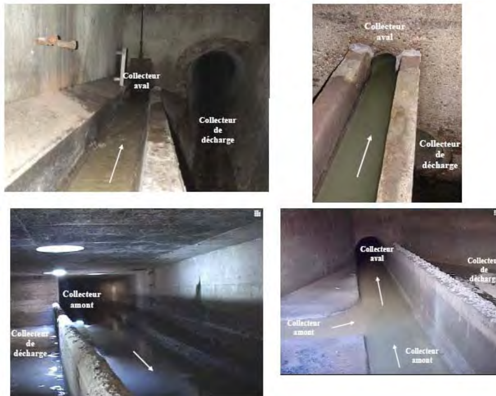
Figure 62 : Illustrations de déversoirs d'orage (ENGES/VEOLIA WATER ANJOU RECHERCHE, 2006)
