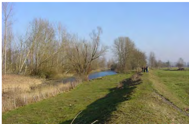
Figure 53 : Une digue de la Moder aval
