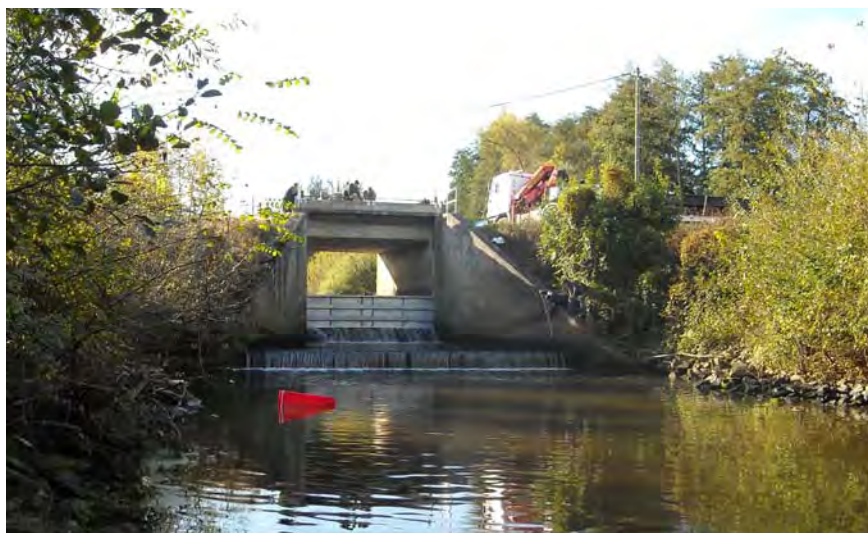
Figure 34 : La Vanne Lerchenberg (Amont Haguenau)
