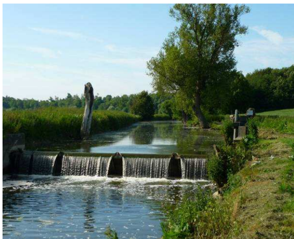
Vanne-clapet d'Evry-Gregy, le 6 juin 2009
