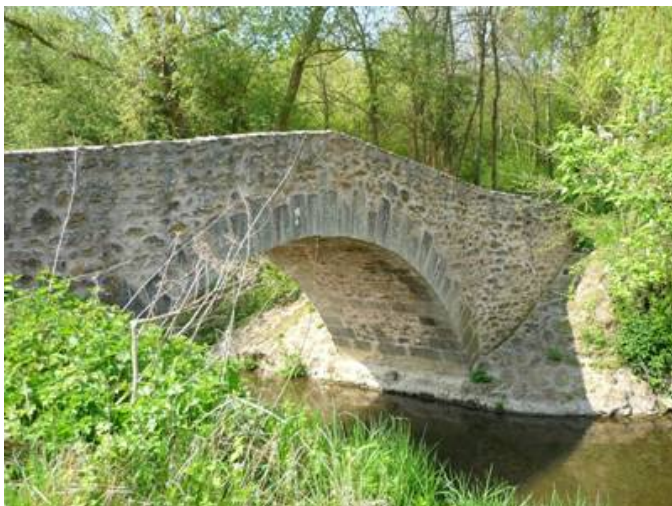
Pont Bossu de Solers
