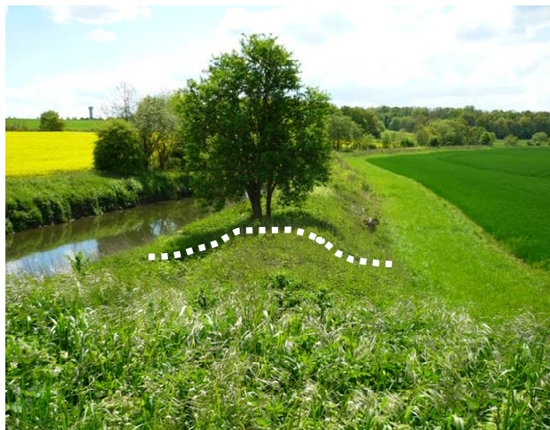
Mise en place de Merlons.
