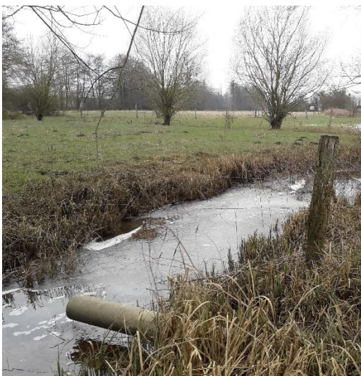
Photos Pnrl : rejets dans un cours d'eau.
