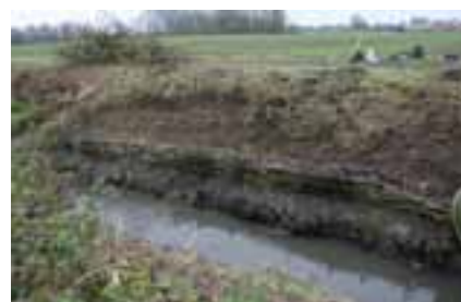
Renforcement de berges réalisé par la CCCO
