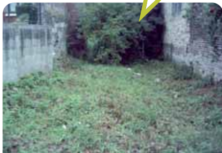
État du bras de la rivière avant les travaux
