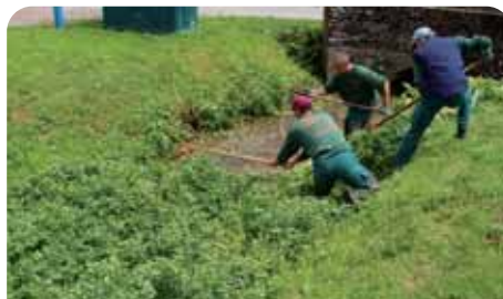
Faucardement en cours : retrait de la végétation aquatique excessive
