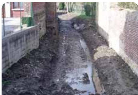
État du bras de la rivière après les travaux
