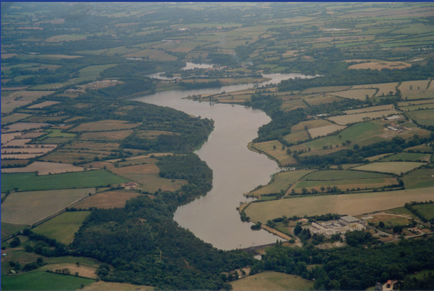
Barrage du Jaunay
