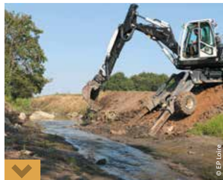
Travaux sur le Dhuy à Vienne-en-Val en 2018
