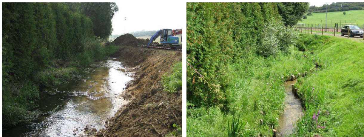
Figure 9 : Reconstitution d'un lit mineur (Avant/Après) – le Billeron (57) –chantier SOGREAH 2006
