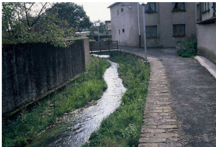
Figure 10 : Aménagement après travaux ruisseau Montvaux (source AERM)
