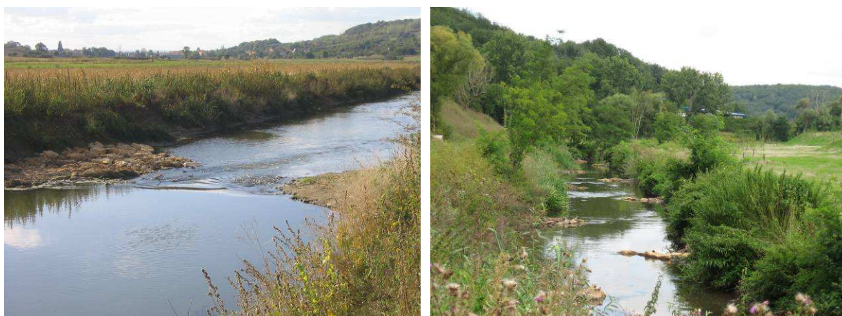
Figure 13 Exemple de réalisation - Epis sur la Seille (source AERM) et la Rosselle (chantier SOGREAH 2006)
