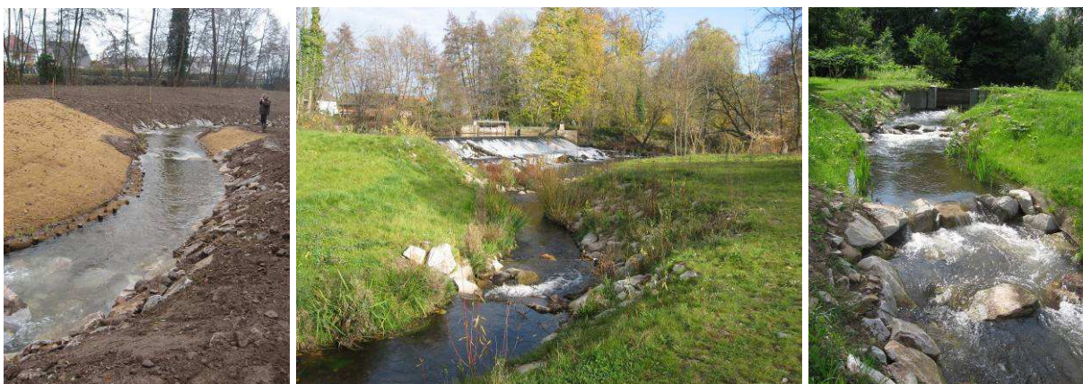
Figure 29 : Rivière de contournement sur la Bruche (21, SOGREAH 2007)
