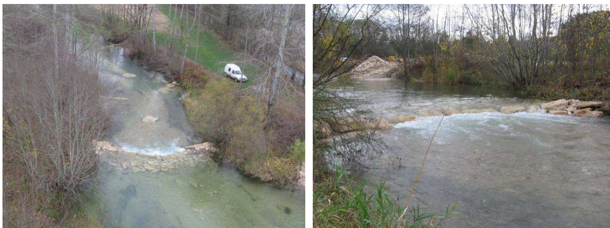
Figure 18 : Exemple de réalisation - Seuil V entrant sur l'Ource (chantier SOGREAH 2008 / 21)
