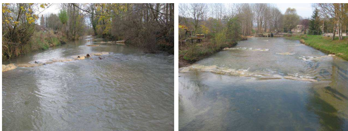
Figure 14 : Exemple de réalisation - Epis entrant sur l'Ource (chantier SOGREAH 2008 / 21)
