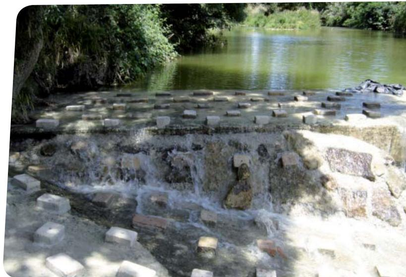
Mise en place de macrorugosité sur le seuil de la RN 113 à Berre l'Étang
