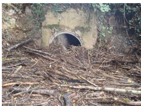
Figure 53 : Photos illustrant à droite l’obstruction d’un passage busé par des rémanents e à droite une coupe forestière dans la forêt des Palanges (PPG HVA 2014)
