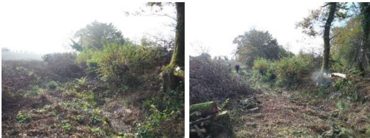
Travaux d'entretien sur le ruisseau de Kernescop à Scaër à proximité d'une ligne EDF
