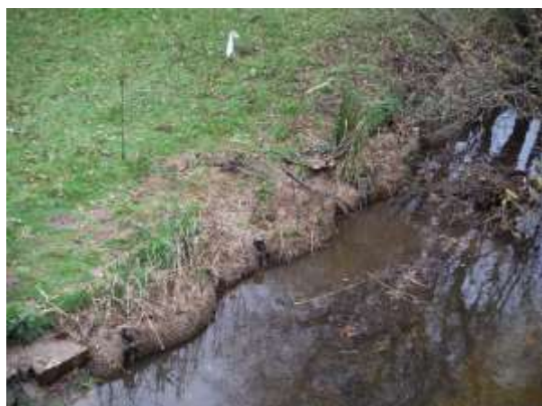
vue du chantier après implantation de baldingères
