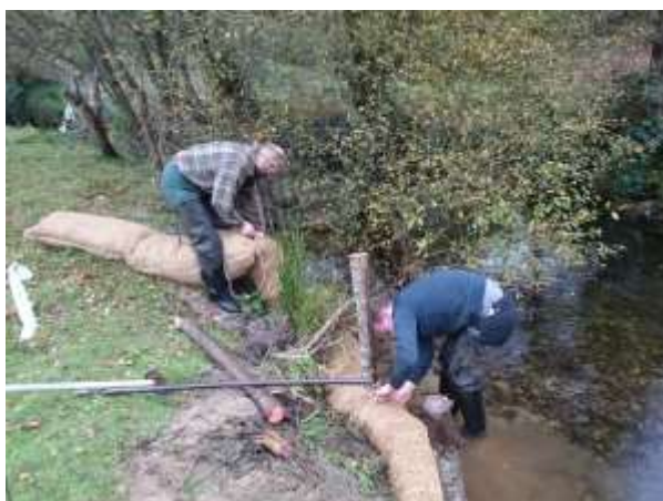
Fixation des boudins avec pieux et ficelle
