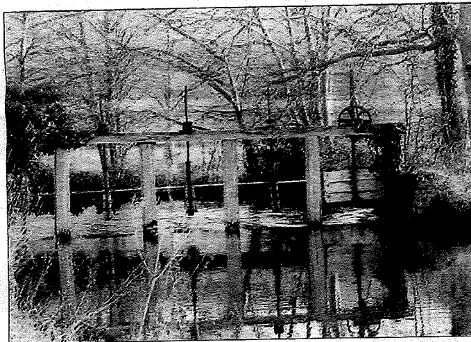
Même très anciens, certains ouvrages ont encore leur utilité.
