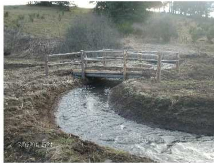
PASSERELLE X : 696195,64 Y : 6505838,44
