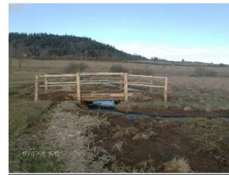
PASSERELLE X : 696045,08 Y : 6505851,26
