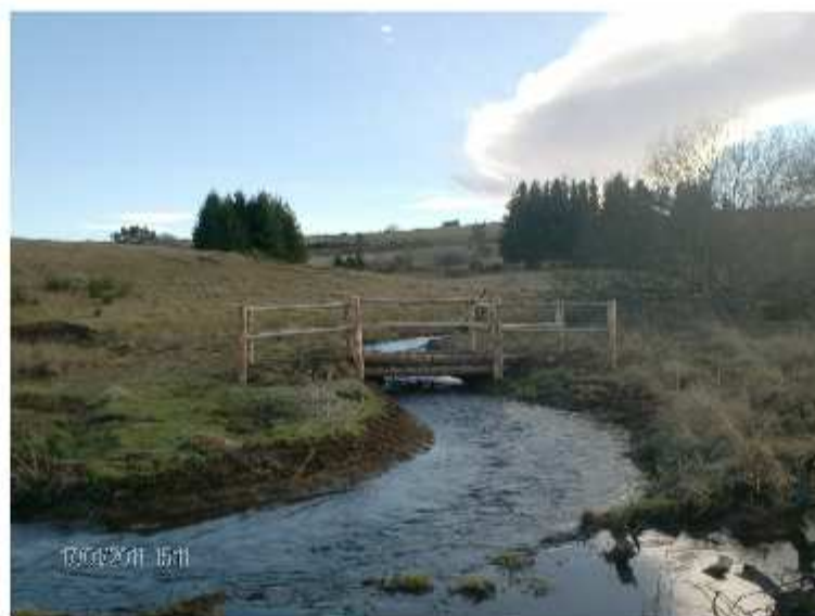
PASSERELLE X : 695966,22 Y : 6505618,1
