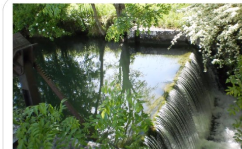
Ouvrage n° 18: Clapet Caractéristiques de l'ouvrage : Longueur : 1,3 m Largeur : 6 m Hauteur : 2,5 m Gestion : publique
