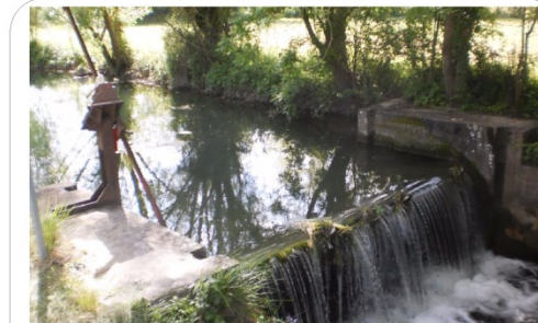
Ouvrage n° 17 : Clapet Caractéristiques de l'ouvrage : Longueur : 5 m Largeur : 6 m Hauteur : 2,2 m Gestion : publique
