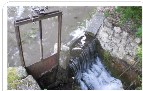
Ouvrage n° 28: Vanne Caractéristiques de l'ouvrage : Longueur : 3 m Largeur : 3 m Hauteur : 1 m Gestion : privée
