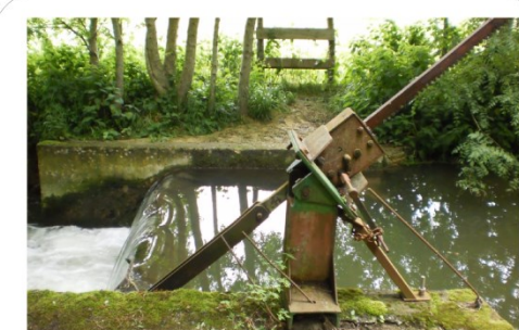
Ouvrage n° 13 : clapet Caractéristiques de l'ouvrage : Longueur : 5 m Largeur : 3,5 m Hauteur : 3 m Gestion: privée
