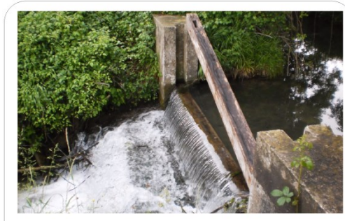
Ouvrage n° 26: Ouvrage à madrier Caractéristiques de l'ouvrage : Longueur : 3 m Largeur : 4,5 m Hauteur : 1,9 m Gestion : publique
