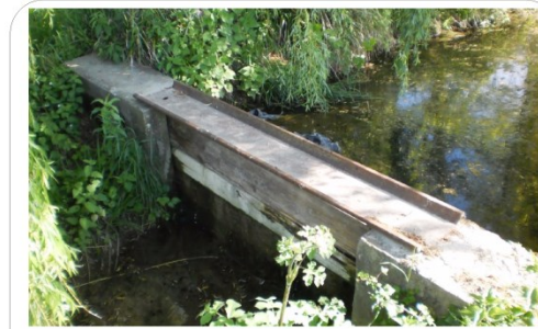
Ouvrage n° 15 : Ouvrage à madrier Caractéristiques de l'ouvrage : Longueur : 0,7 m Largeur : 3 m Hauteur : 1 m Gestion : publique
