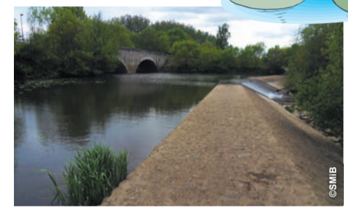
Chaussée sur l'Èvre (Le Marillais)
