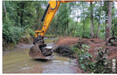
Pose de blocs épars
