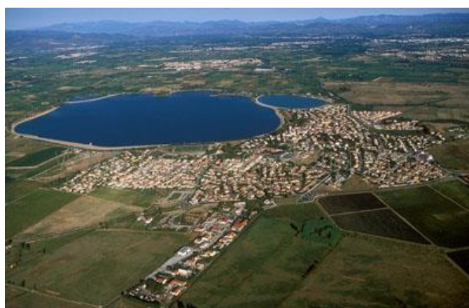
Figure 8 : LAC DE RETENUE DE VILLENEUVE DE LA RAHO
