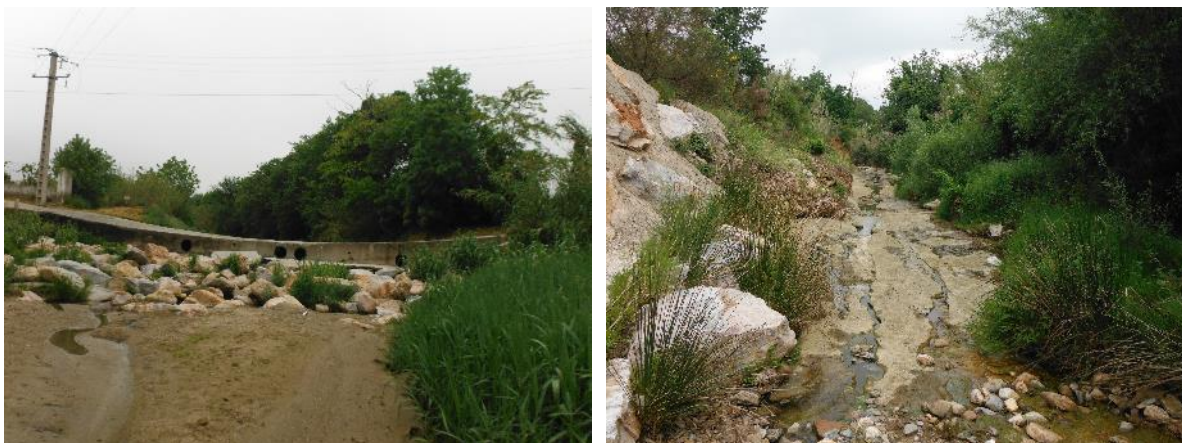
Figure 13 : EXEMPLES DE PASSAGE A GUE ET DE ROCHE MERE AFFLEURANTE A L'AVAL
