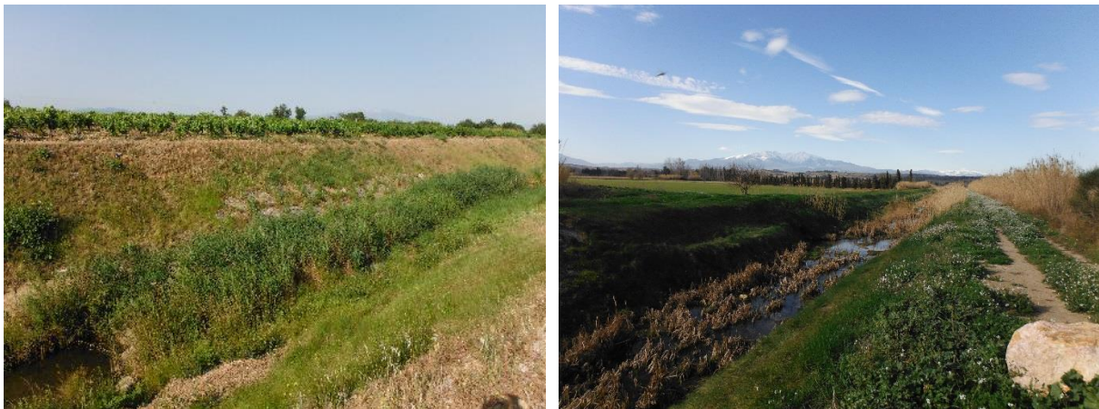
Figure 15 : LA FOSSEILLE (PHOTO DE GAUCHE) ET L'AGUILLE DE LA MAR (PHOTO DE DROITE)
