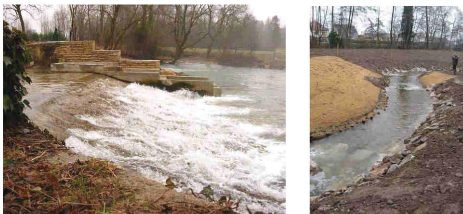
*Exemple de réalisations SOGREAH : Passe à bassin successifs (21) et rivière de contournement (67)*
