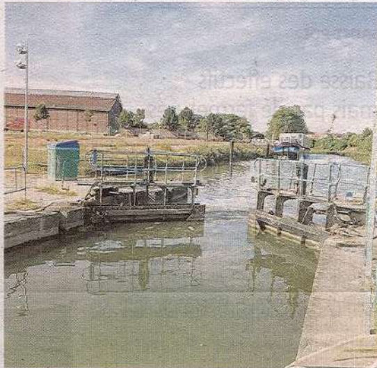
La Scarpe canalisée, ici au niveau de l'écluse entre Saint-Nicolas et Arras, a fait l'objet de travaux de dragage. PHOTO ARCHIVES « LA VOIX »
