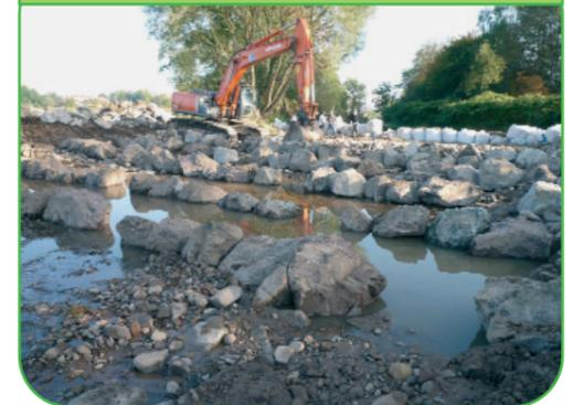
La brèche existante dans la berge du Breuchin a été stabilisée par la mise en place d'une rampe en enrochements franchissable.
