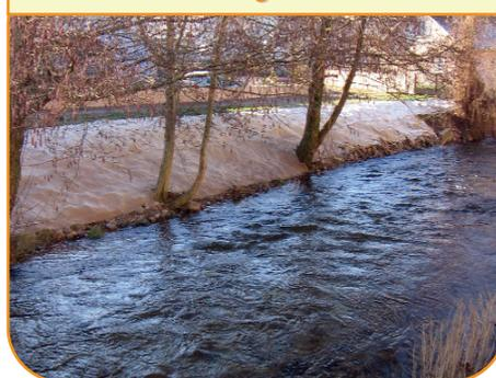
Sur le secteur du Val d'Ajol, la présence d'enrochements a nécessité la pose d'un géotextile sur l'ensemble du talus
