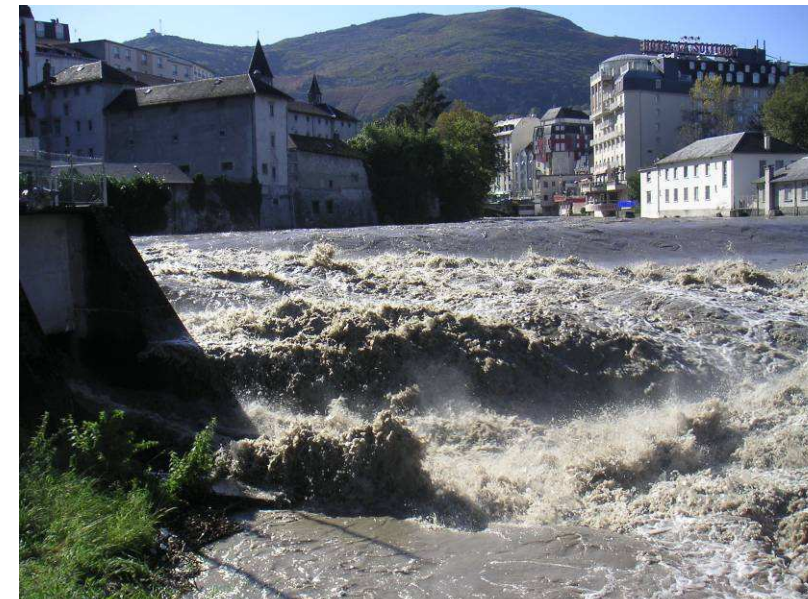
Protection contre les risques liés aux crues
