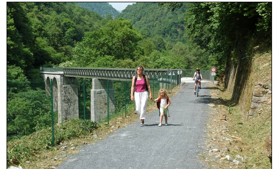
Tronçon Pierrefitte-Nestalas / Cauterets
