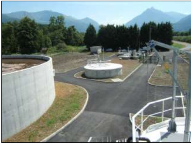
Nouvelle STEP d’Argelès-Gazost (2007)
