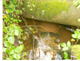
Le diamètre des buses est sous dimensionné. Les buses ont été partiellement soulevées
