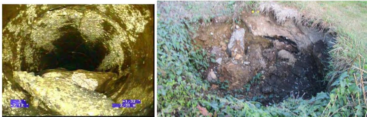
Figure 9 : Effondrements observés au niveau de la zone de Coat conq à Concarneau.
