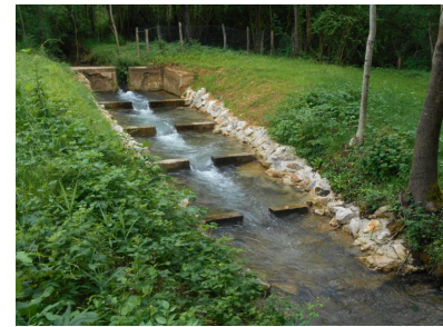
Pré-barrages au Moulin des Etangs à Féney
