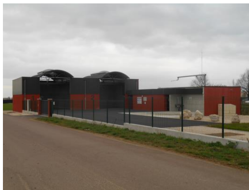
Aire de lavage collective des pulvérisateurs viticoles de Brochon – Gevrey-Chambertin (photo SBV)
