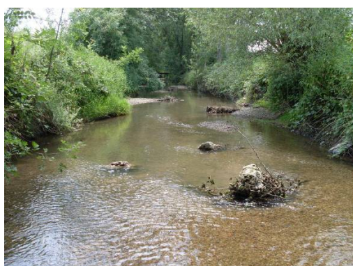
Photo 4 : Fixation d'embâcles, mise en place de blocs de pierre et d'épis sur le Meuzin
