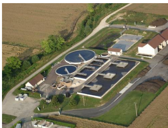
Photo 1 Réhabilitation de la Step Quincey (traitement NP + plate forme compostage)
