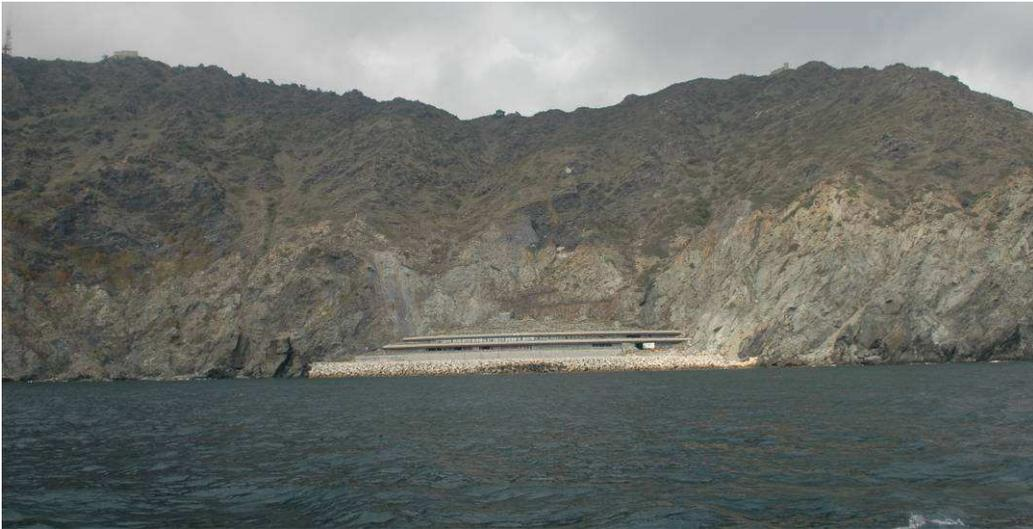
Figure 23 : Station d'épuration d'Amphitria. D'importants investissements ont été réalisés afin d'intégrer la STEP dans ce paysage de falaises fortement exposées aux aléas climatiques. Son émissaire se rejette dans les petits fonds (-8m) dans la petite baie qui lui fait face.
