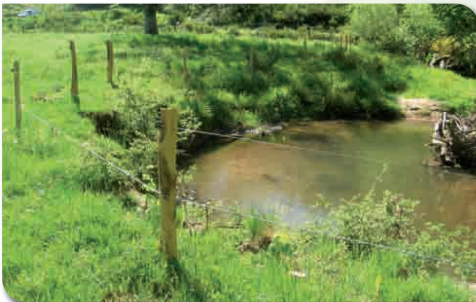
Exemple de travaux qui ont été effectués : le retrait des clôtures par rapport à la berge.
