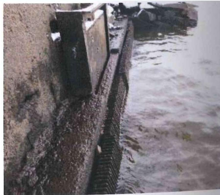
Vues sur les grilles de prise avec le plan d'eau à la cote 1242.50 environ
