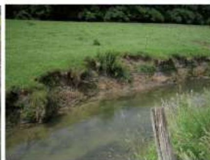
Gestion des érosions de berge
