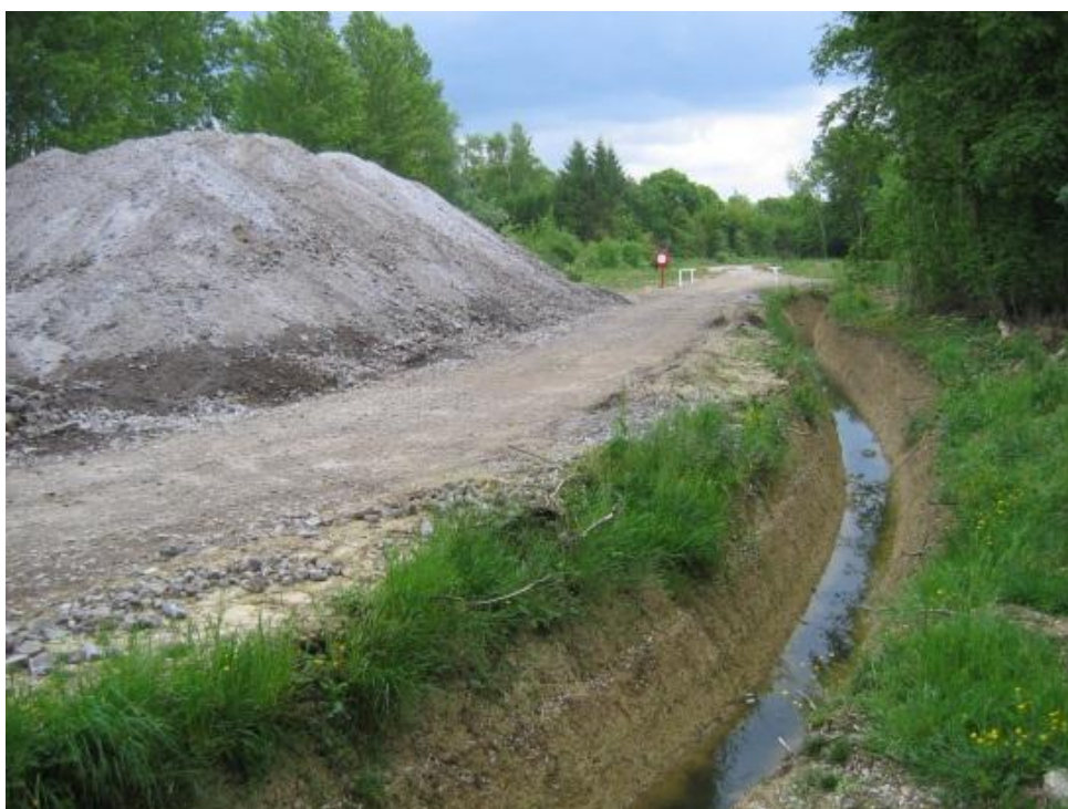
Figure 4 - Des travaux d'amélioration de la desserte
