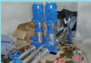
^ En haut, l'ancien équipement. En bas, le nouveau matériel.
