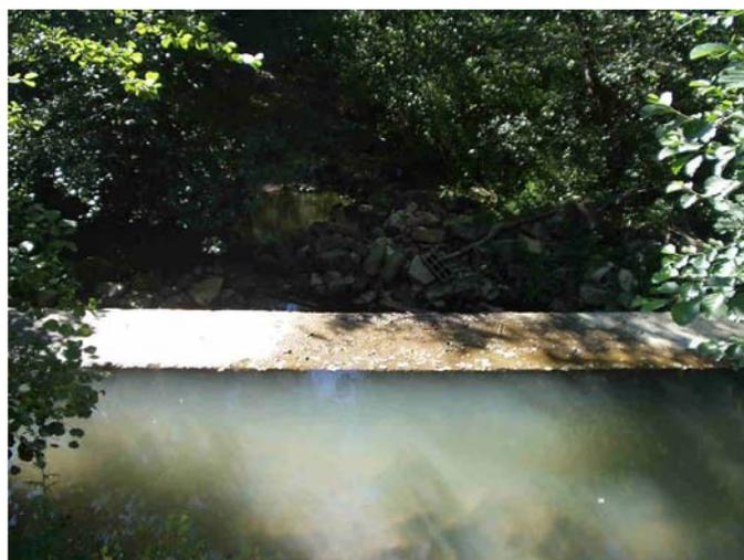
La Calonne est très aménagée sur ce tronçon à cause des prises d'eau des deux moulins. De nombreux seuils existent et maintiennent le profil en long. En aval du pont de la Poipe, il existe une zone de « décharge » sauvage où les gens jettent le plus souvent des déblais de démolition. Le lit mineur de la rivière peut s'en trouver en partie obstrué et la qualité de l'eau dégradée.
